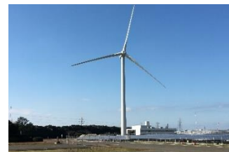
エネ・シールド北九州風力発電所
