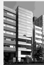
麹町HFビル
