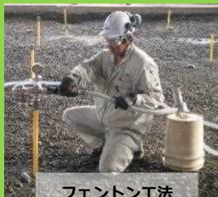
フェントン工法
