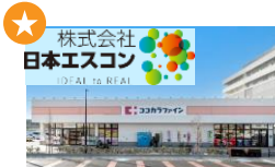
ココラファイン寝屋川公園店 (底地) (大阪府寝屋川市)
