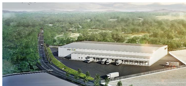
ちばリサーチパークプロジェクト (仮称) (千葉県)
