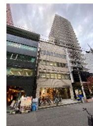
大和本町ビル
