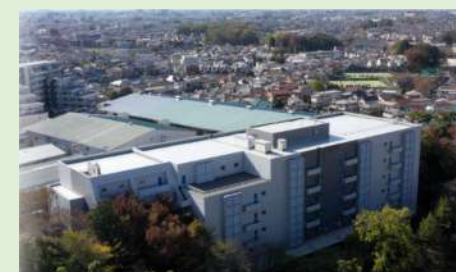
東京第一物流センター
