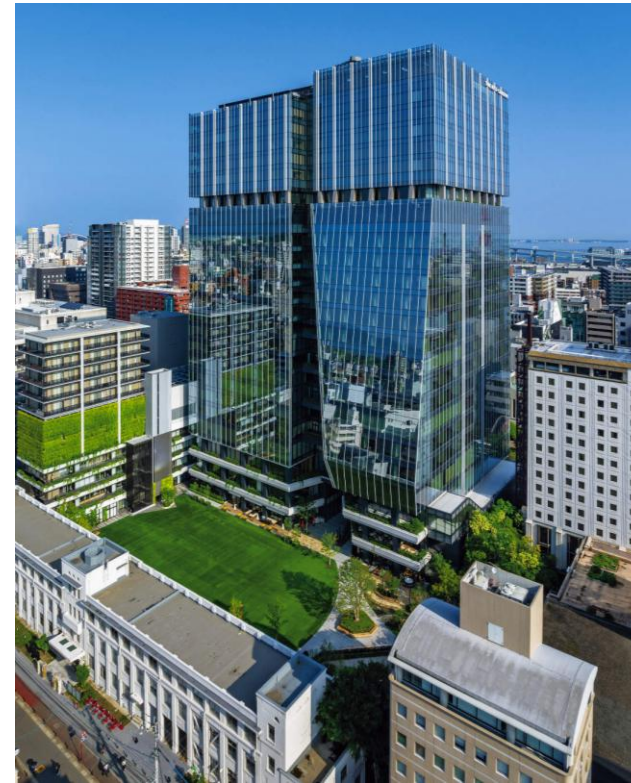
大名ガーデンシティ ザ・リッツ・カールトン福岡 (福岡市中央区)
