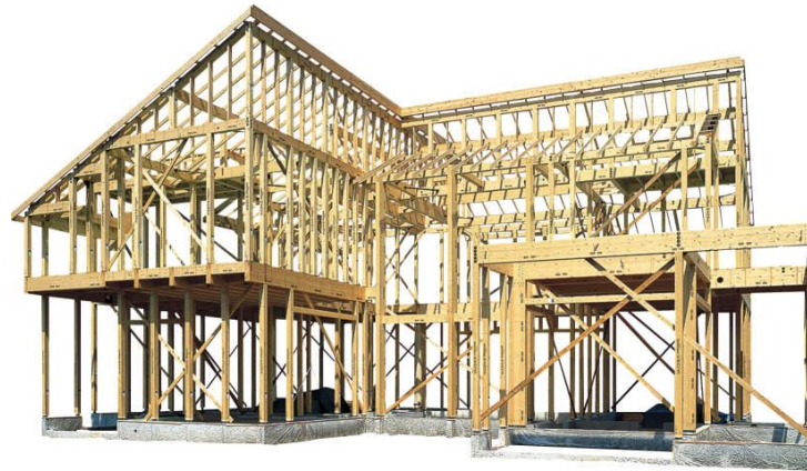
木造住宅 「シャーウッド構法」
