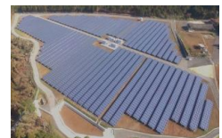
S-09 CS芦北町発電所
