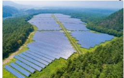
S-17 CS大山町発電所(A) 同発電所(B)
