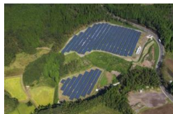
S-05 CS湧水町発電所
