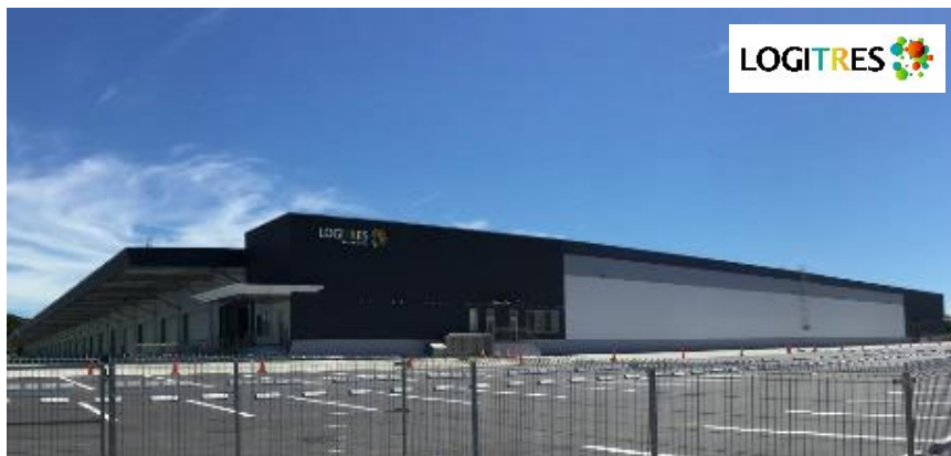
ロジトレス東条 (兵庫県加東市)
