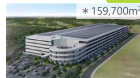
New * 159,700m 2 プロロジスパーク八千代1 (千葉県八千代市) 2022年9月竣工予定
