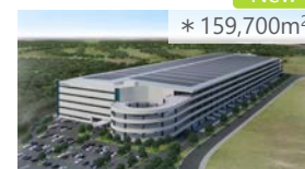
New * 159,700m 2 プロロジスパーク八千代1 (千葉県八千代市) 2022年9月竣工予定
