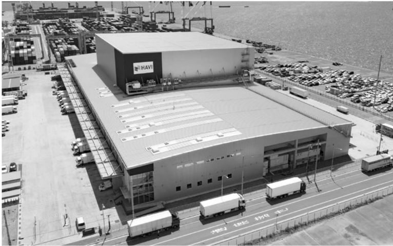
六甲アイランドDC外観
