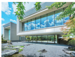
郡山モノリス(福島県郡山市)
