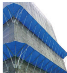
くさび緊結式次世代シート朝顔
