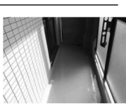
バルコニー（壁面補修、 床ウレタン防水補修）
