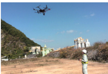
ドローンによる航空写真測量
