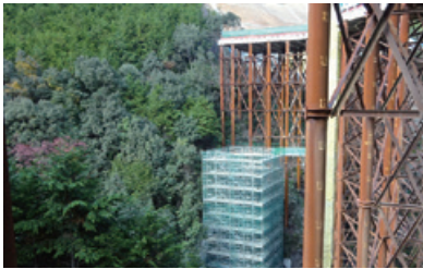
橋梁下部工事
