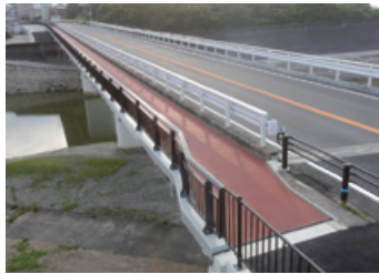
交通安全対策工事
