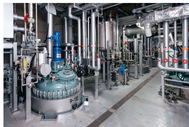
本社 医薬品工場 原薬合成設備
