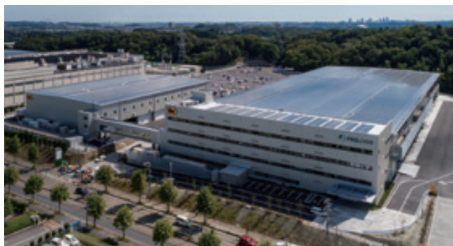
B-16 プロロジスパーク仙台泉2 (宮城県仙台市)
