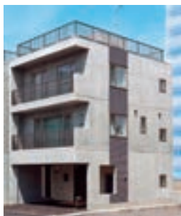
■エステティカ外観施工例
