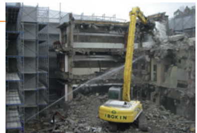
〈ビル解体工事〉
