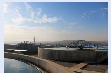
拡張工事が行われた浄水場(写真: JICA)
