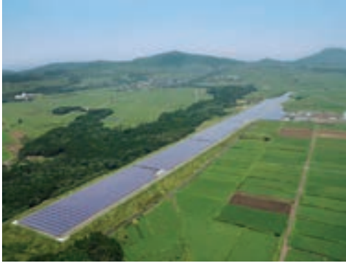
事業投資事業部門 環境エネルギー事業 メガソーラー発電事業（鹿児島県枕崎市）
